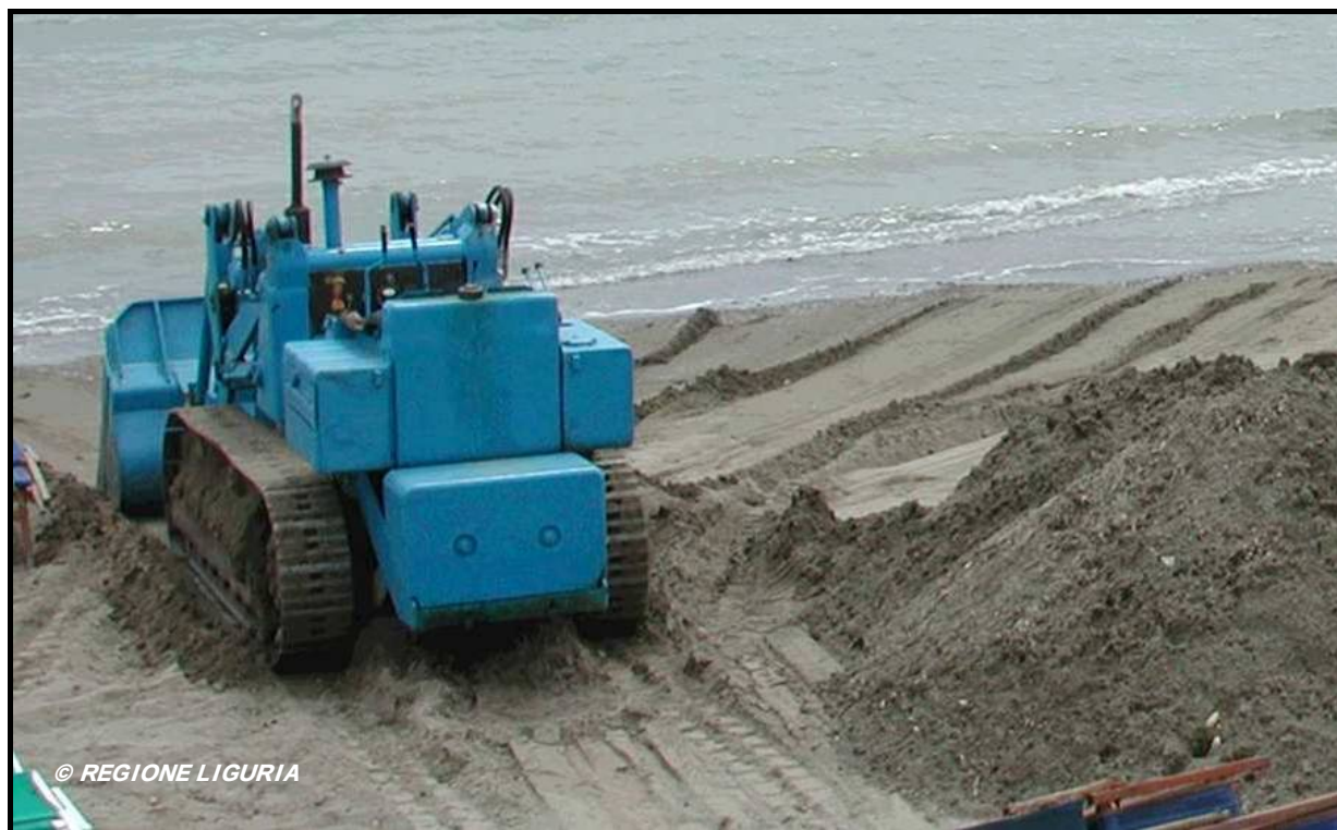
Figure 1- Exemple de travail de rechargement des plages.
