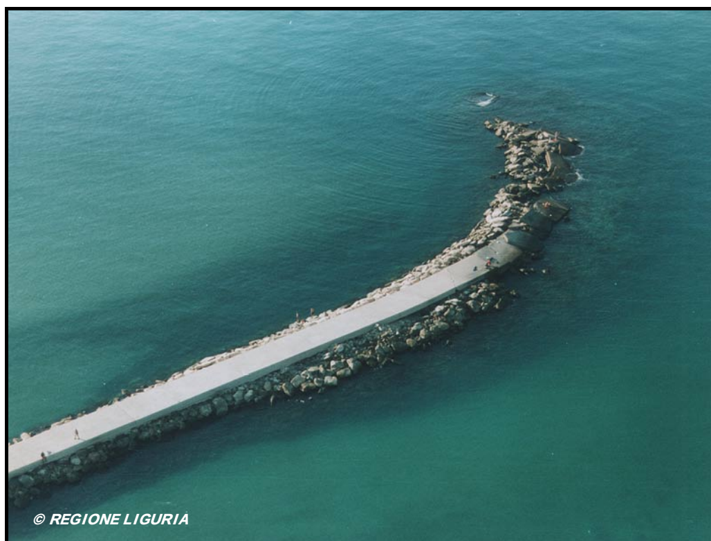
Figure 2 – Exemple d’un ouvrage littoral
