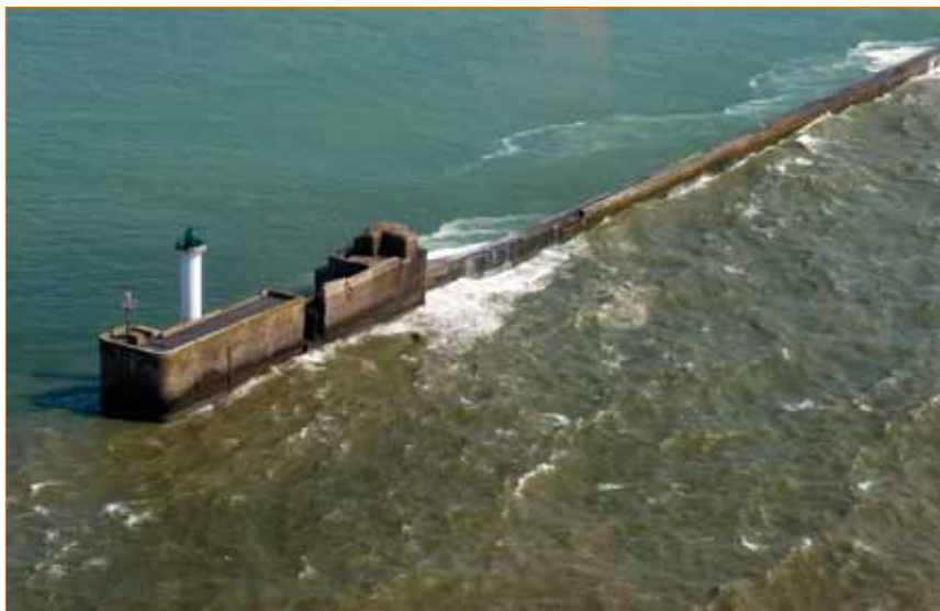
Digue à Boulogne-sur-Mer, dans le Pas-de-Calais (62).
